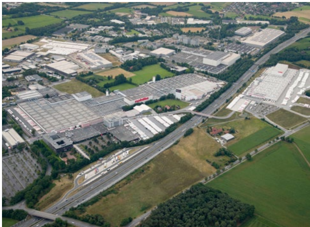
Werk I in Verl-Sürenheide und Werk III in Gütersloh 113.000 m 2 und 35.000 m 2
